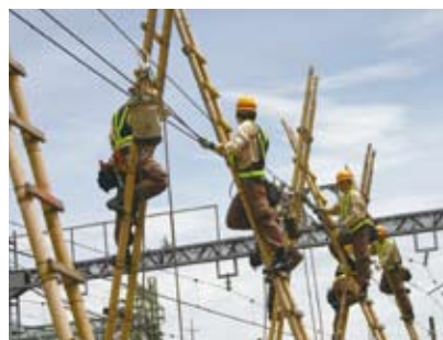
▲電車線・ちょう架線断線復旧訓練
