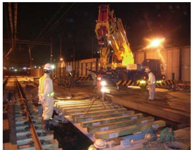
▲工事桁架設工事
