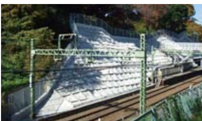
▲弘明寺駅構内
