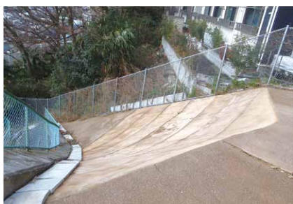
▲南太田～井土ヶ谷駅間
