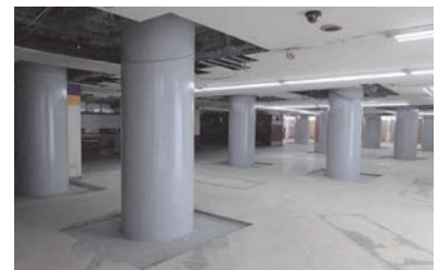
▲平和島駅構内(平和島駅構内高架橋)
