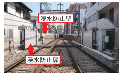
▲大鳥居駅トンネル入口(京急蒲田方)
