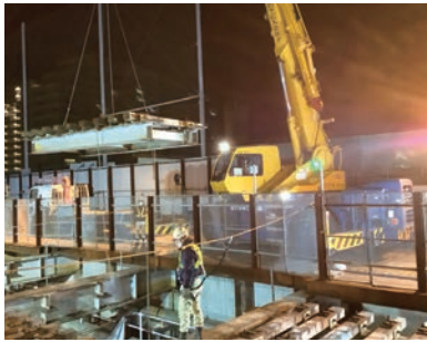
▲地上部の仮橋の撤去
