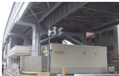
▲新馬場駅構内(新馬場第1架道橋【環状6号線】)
