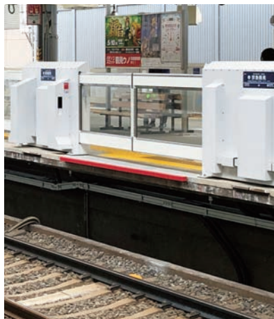
▲京急鶴見駅 上りホーム
