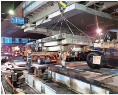
▲旧産業道路踏切部の踏切版の撤去
