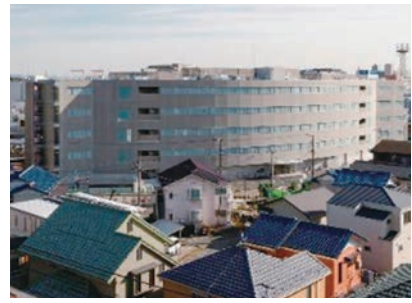
▲金沢文庫現業事務所 外観
