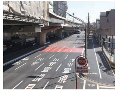
▲旧産業道路踏切部の道路復旧完了
