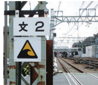
▲津波浸水区間表示板
