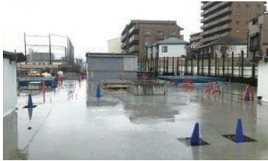
▲大師橋駅駅舎の基礎構築
