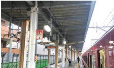
▲小島新田駅ホームの本設上家設置
