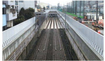
▲トンネル坑口の浸水防止壁の設置
