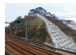
杉田駅～京急富岡駅間上り線側
