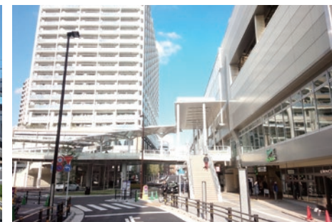
京急蒲田駅 西口側
