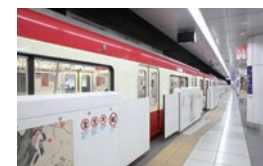
羽田空港国際線ターミナル駅に設置しているホームドア
