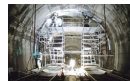
トンネルの補修工事の様子
