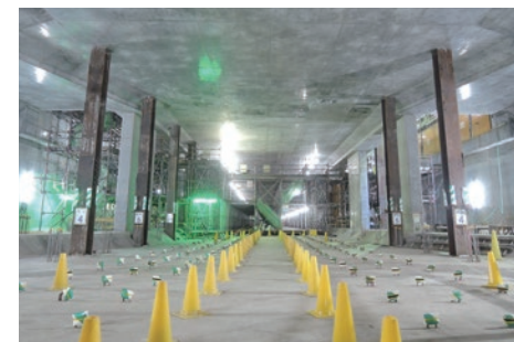
産業道路駅付近での躯体構築状況
